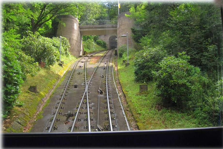
Der abwärtsfahrende Wagen zieht den aufwärtsfahrenden Wagen hoch. Für den zusätzlich nötigen Antrieb sorgt ein 125 KW / 170 PS Motor in der Bergstation. In der Mitte der überwiegend eingleisigen Strecke befindet sich ein kurzer zweigleisiger Streckenabschnitt mit Abtscher Weiche. Hier fahren die Wagen aneinander vorbei.
